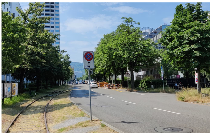
Abbildung 3: Flurstrasse (Abschnitt Nord, Basler- bis Hohlstrasse), Blick in Richtung Süden
